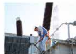
نصب و راه‌اندازی
