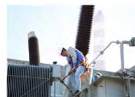
نصب و راه‌اندازی
