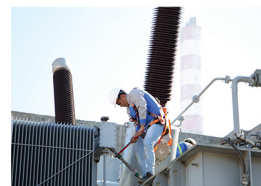
نصب و راه‌اندازی
