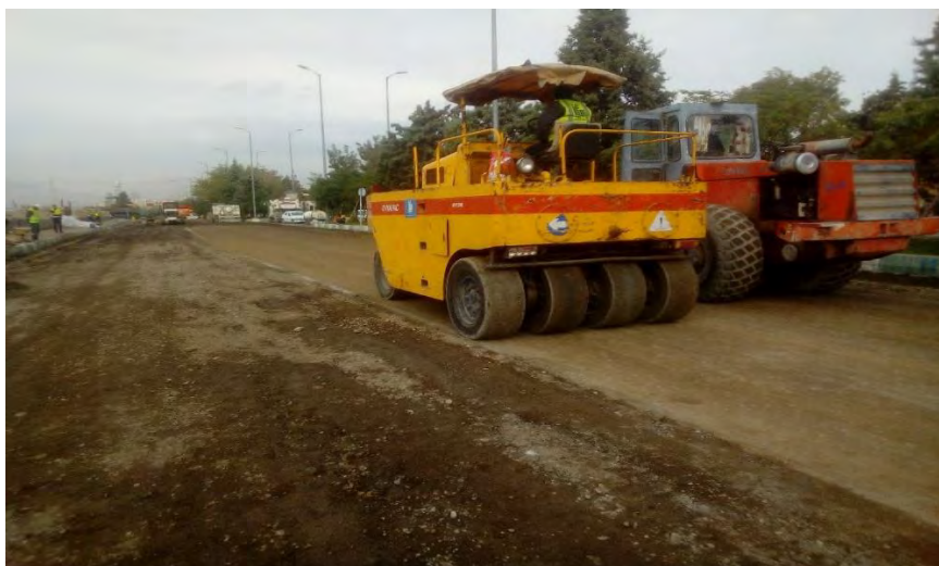
کمپکت نمودن سطح پروفیله شده با غلطک لاستیکی
