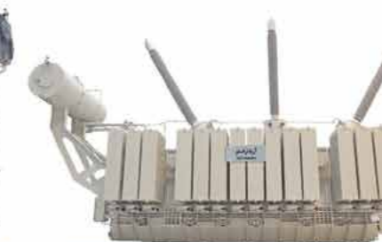
ترانسفورماتور قدرت مجتمع صنعتی و معدنی کل‌کل سیرجان توان 270 MVA، ولتاژ 400/33 kV
