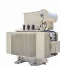
ترانسفورماتور نیروگاه خورشیدی توان 2500 kVA، ولتاژ 0.4/20 kV
