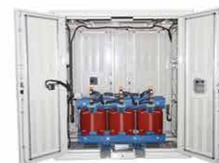
ترانسفورماتور خشک با اینکپوزر توان 125 kVA، ولتاژ 0.4/0.42 kV
